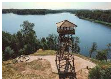
Skatu torņa izbūve un atpūtas vietas ierīkošana Cieceres ezera krastā (2018.)
